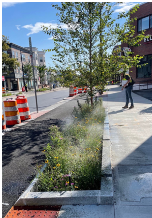
Recém instalados canteiros e flores plantadas na Somerville Avenue. A Cidade plantou 518 árvores em 2021.
